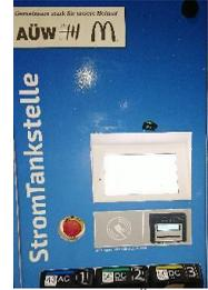
Abbildung 4: Öffentliche Mehrsystem-Schnellladestation
