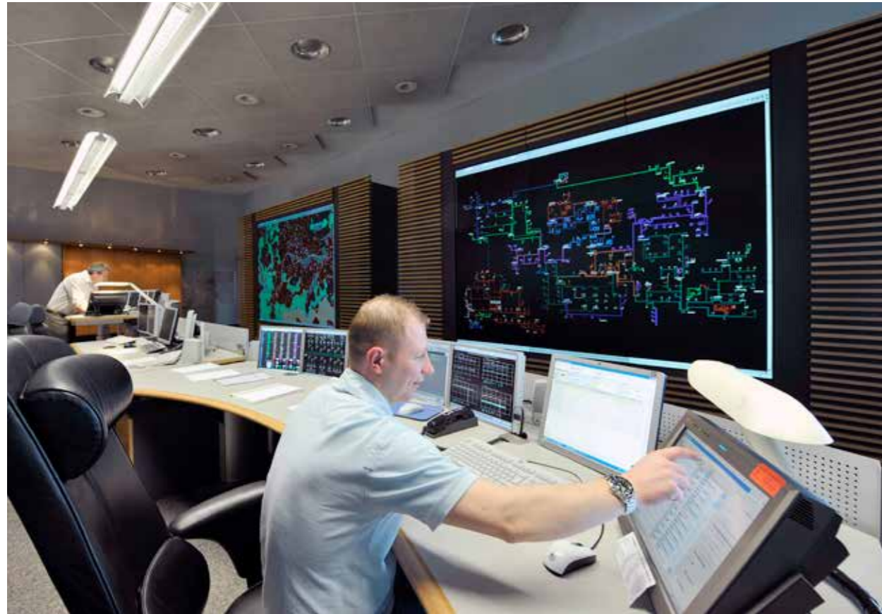
Mit PSIconrol ausgestattete Leitwarte der Westnetz GmbH (RWE AG)
